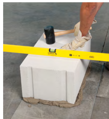
Выравнивание с помощью уровня и резинового молотка
