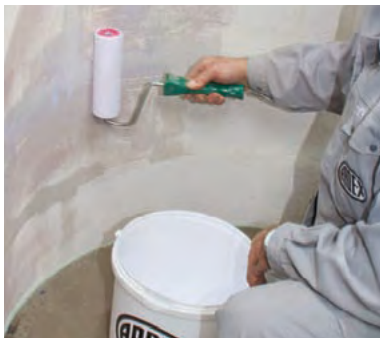
Нанесение влагостойкого грунтового покрытия
