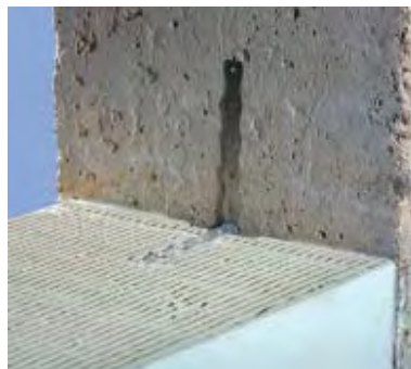
Примыкание к железобетонной колонне
