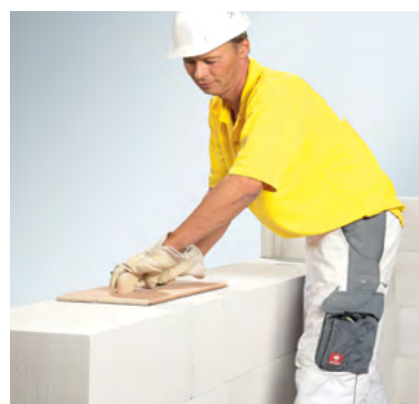
Выравнивание с использованием шлифовальной доски
