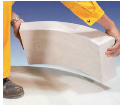
Укладка первого ряда дугообразных блоков
