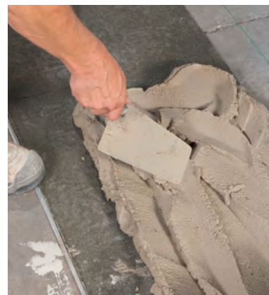
Нанесение первого слоя цементно-песчаного раствора на фундаментное основание
