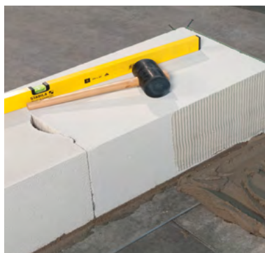
Готовая кладка 1-го ряда на растворе
