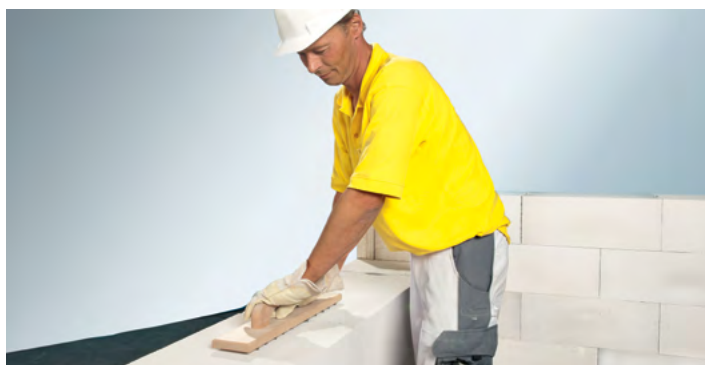
Шлифовка с использованием рубанка
