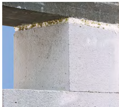
Примыкание к железобетонному ригелю
