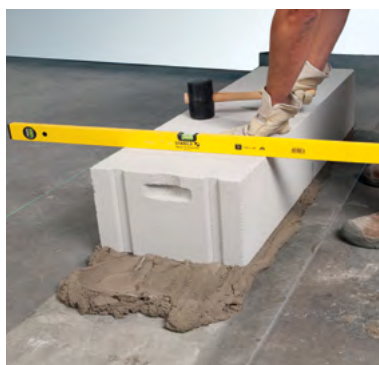
Выравнивание с использованием уровня и резинового молотка
