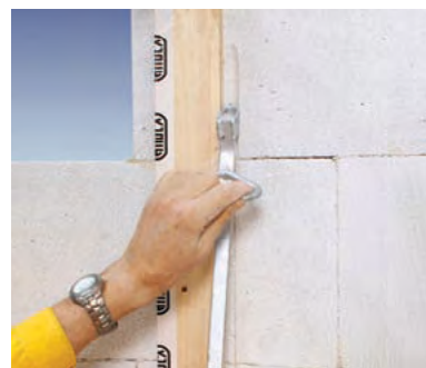
Изготовление каналов для прокладки электропроводки
