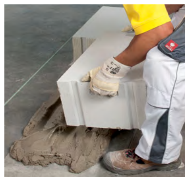
Установка первого ряда блоков
