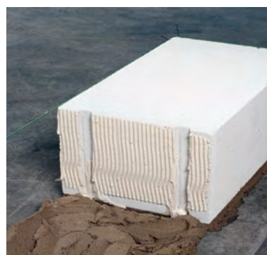
Вертикальный шов первого углового элемента
