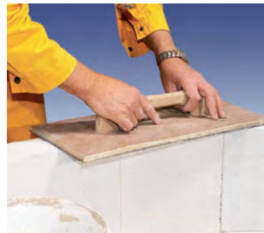
Обработка поверхности кладки шлифовальной доской
