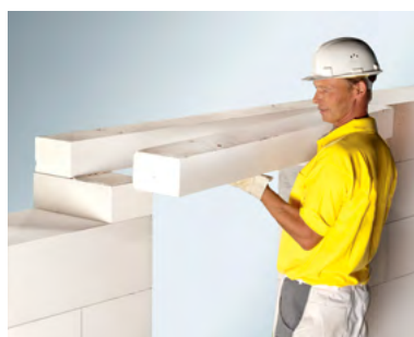
Укладка перемычки ПН125
