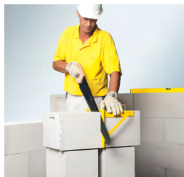
Резка вручную
