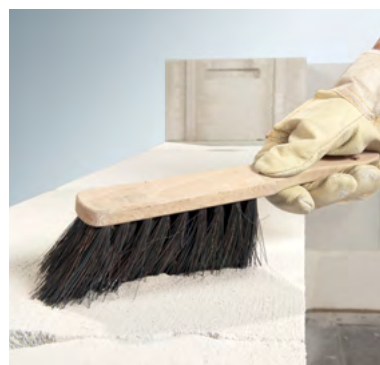
Удаление пыли и загрязнений при помощи щетки
