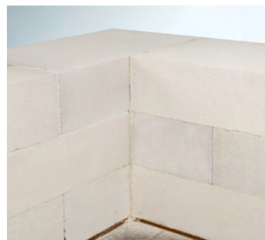
Правильное соединение угловых элементов
