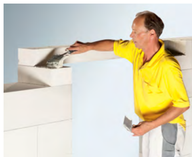
нанесение раствора для тонкошовной кладки ISTKULT
