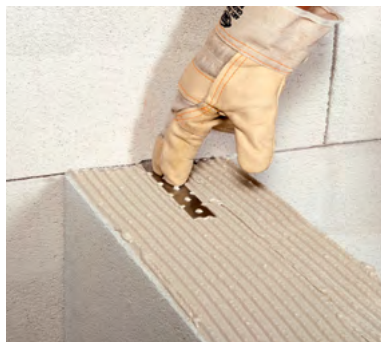
Закладка связи в шов примыкающей стены
